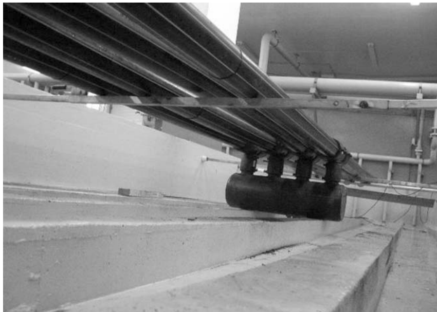
El sistema de tuberías, listo para la prueba.
