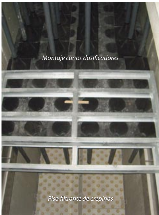
Detalle del montaje de la celda
