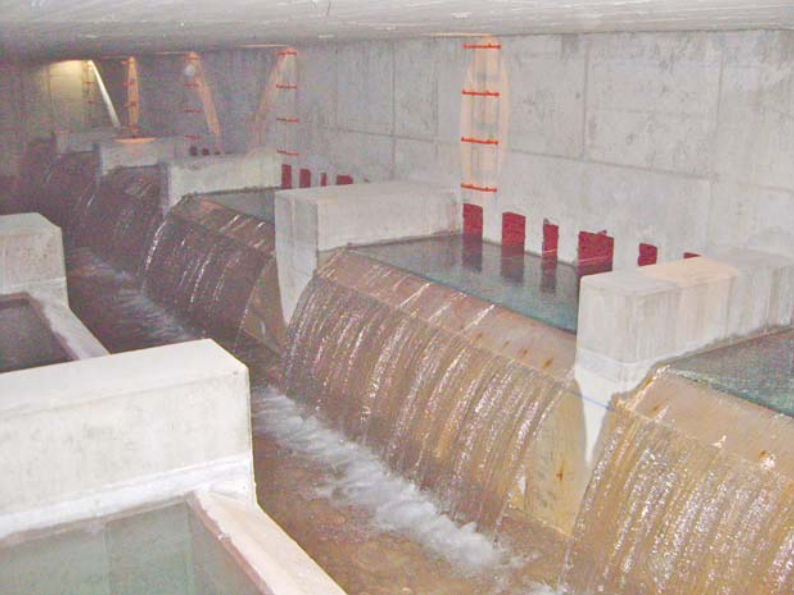
Salida de la planta de remineralización con \text{CaCO}_3 y \text{CO}_2 para 200 MLD. UTE-Dessaladora Area Metropolitana de Barcelona
