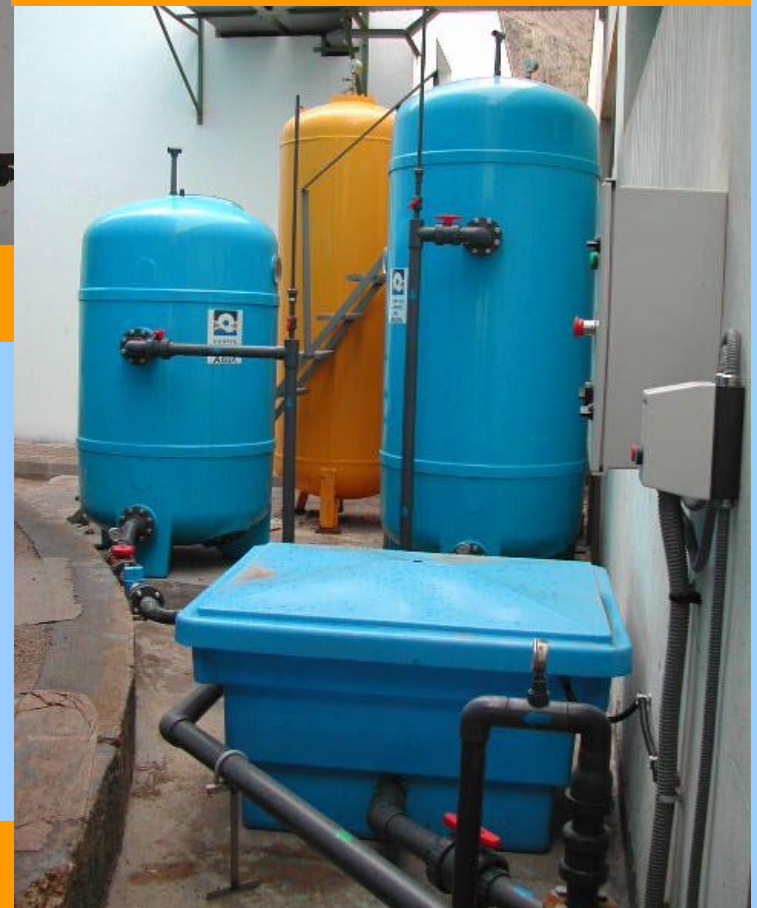
Prototipos instalados en Las Palmas III (300 y 420 m 3 /d, depósitos azules (2003)
