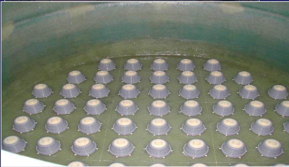
Depósito dosificador de carbonato cálcico tipo Aquatron ® para 316 m 3 /d.
