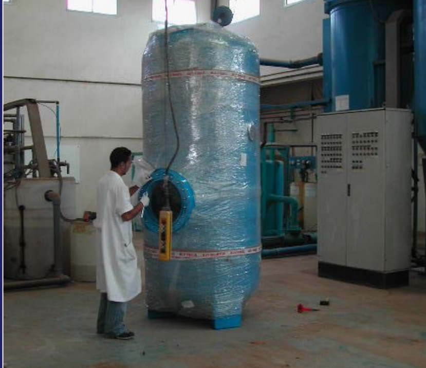
Depósito dosificador de carbonato cálcico tipo Aquatron ® para 316 m 3 /d.
